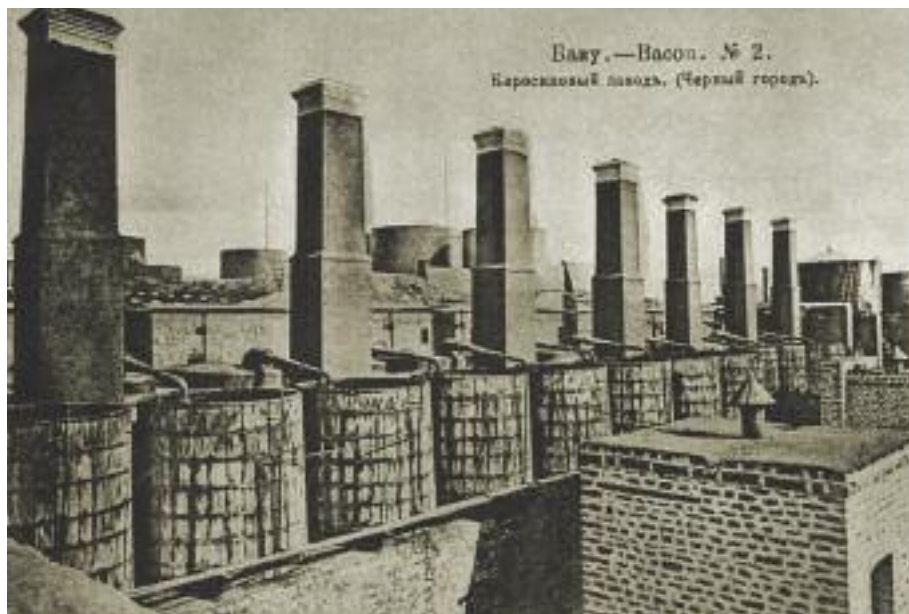
Один из первых нефтеперегонных заводов на Апшеронском полуострове (1870-е гг.)
