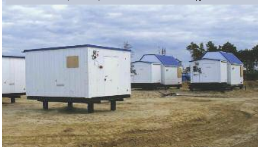
Рис. 3. Установка «Мера-Массомер» с блоком газоаналитического оборудования
