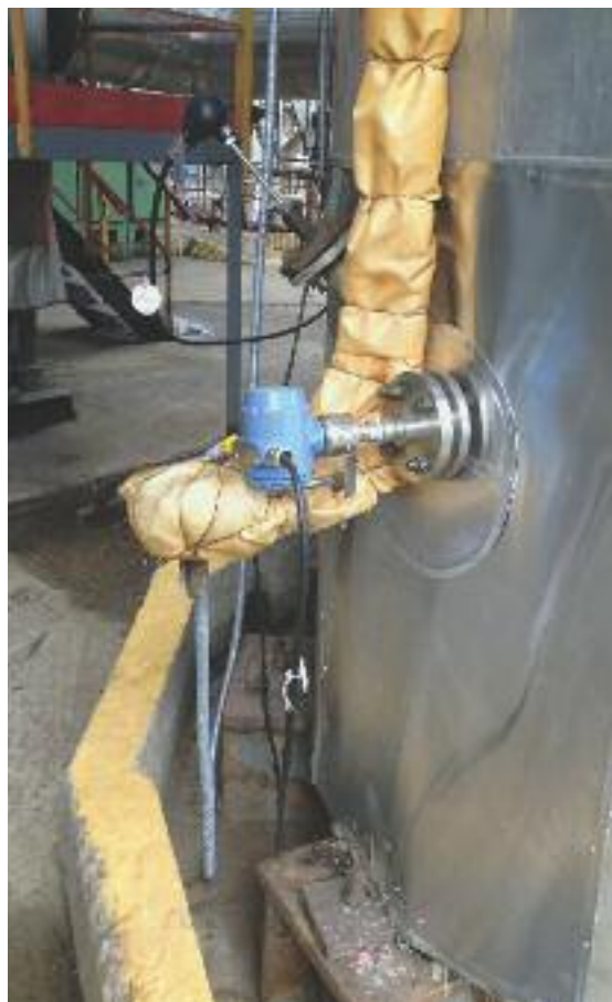
Место установки. Представьте, что можно вообще забыть о том, когда последний раз делалась проверка работы системы измерения уровня, так как ни капилляров, ни импульсных линий попросту нет
