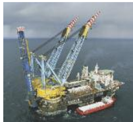
Судно-трубоукладчик «Сайпем 7000» производит укладку газопровода «Голубой поток», Чёрное море, Россия, 2002 год
