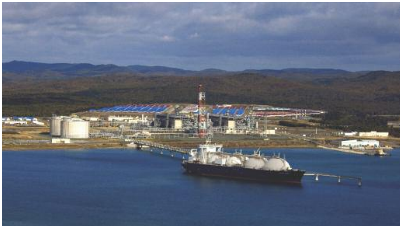
Завод СПГ на Сахалине
