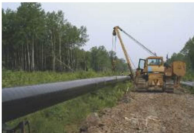
Прокладка нефтепровода Комсомольск-на-Амуре – Владивосток
