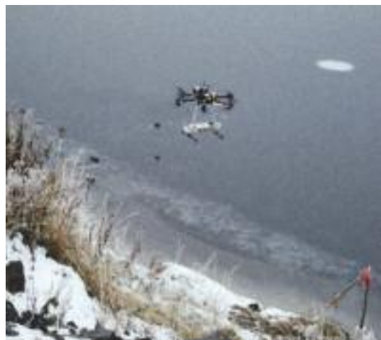
а) Водный переход газопровода компании ОАО «АЛРОСА – Газ» через реку Большая Ботуобия шириной более 200 м, Якутия
