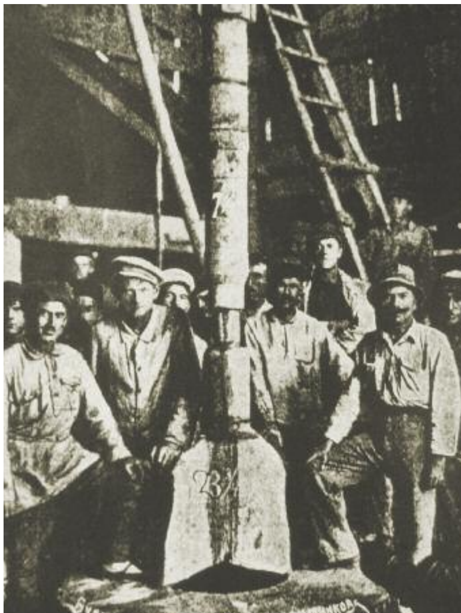
Испытание турбобура Капелюшникова в Баку
